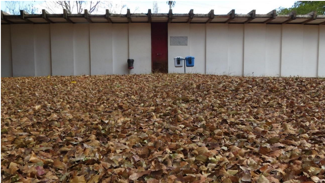
Figura 1: Fachada do SG 10, edifício que abriga o Ceplan.
