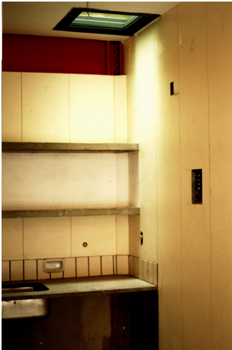
Figura 20: Fotografia de Luz Natural entrando por um duto de Luz e Sol sobre a bancada da cozinha, logo após a construção. Acervo do autor
