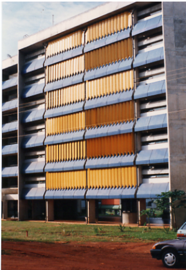
Figuras 10 e 11: Controladores de Sol horizontais e verticais nas Fachadas NW-W de dois edifícios, vendo-se no da direita varandas e, também floreiras visando controle do sol na empena (arquivo do autor).
