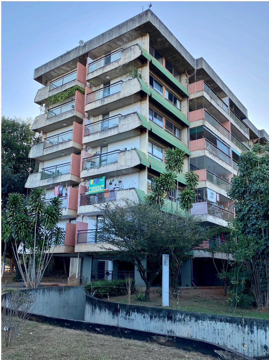
Figura12: Vista do Bloco E vendo-se á direita fachada NE-L, com controles horizontais, como beirais, placas verdes pré-fabricadas horizontais e varandas. E na fachada SE-S à esquerda, sacadas e floreiras. Arquivo do autor.
