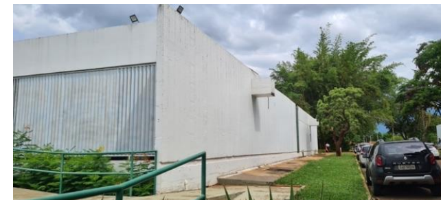
Figura 39 – Fachada Oeste FE3. Foto: Flaviana Barreto Lira, 2022.
