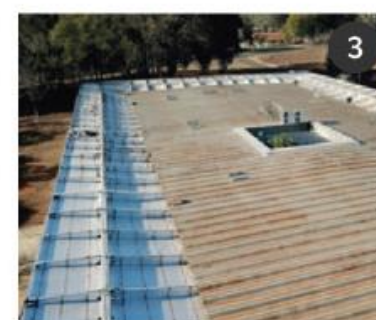
Cobertura com telha perfurada
