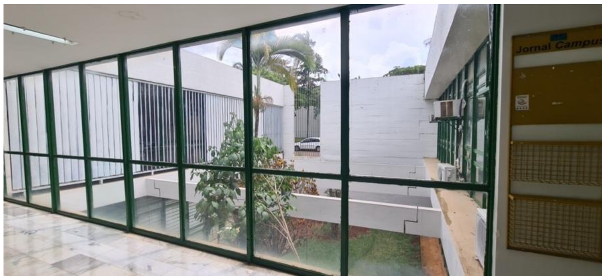
Figura 32 – Vista do pátio interno a partir da faixa de circulação pública em “ponte” do térreo. Notar detalhe do encaixe “positivo-negativo” mencionado por Puhl (2010) das vigas, mais conhecido como dente ou apoio Gerber que formam o pergolado sobre o jardim no semienterrado. Fonte: Flaviana Barreto Lira com marcação dos autores.
