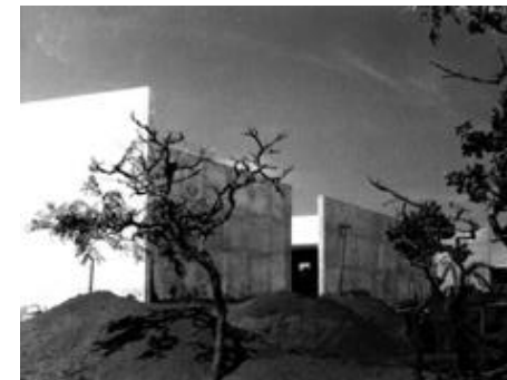
Figura 48 – Fachada Norte, FE5 em construção onde se percebe o rasgo vertical e os planos das fachadas Leste e Oeste que avançam. Fonte: Arquivo Central da UnB.
