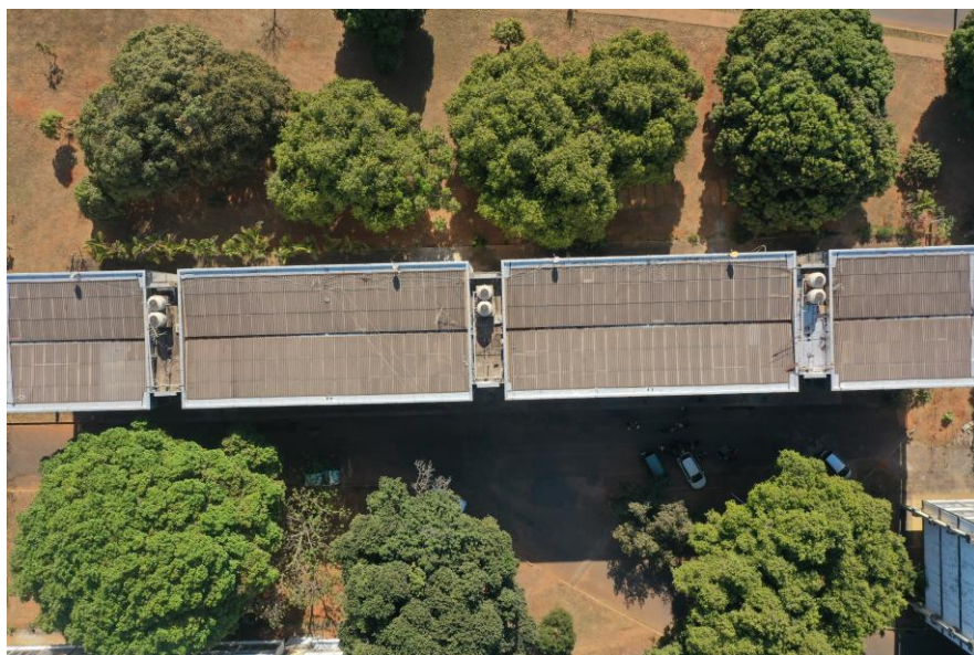
Figura 90 - Cobertura do Bloco A – Colina: imagem capturada por drone. Fonte: LaSUS, 2022.
