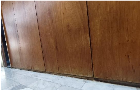
Fig. 3 - Divisórias com esfoliamento das lâminas de madeira.
