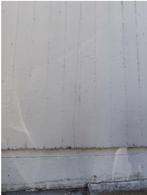
Fig 2. Parede de concreto armado aparente do subsolo: Vista externa da parede oeste em concreto aparente pintado com látex acrílico na cor branca.
