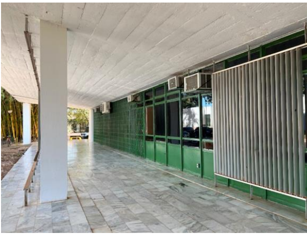
Figura 23 – Fachada FE1 mostrando brise-soleils junto à esquadria. Fonte: Equipe Grupo de Pesquisa Conservação Manutenção, 2022.
