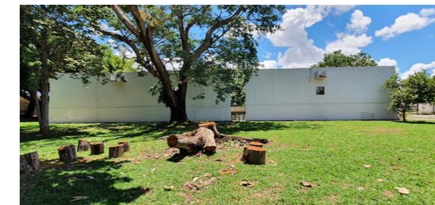
Figura 40 – Fachada Leste com detalhe da esquadria quadrada. Fonte: Oscar Luís Ferreira, 2022.
