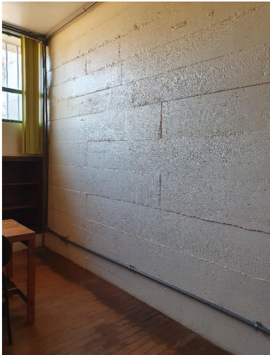
Fig.1 Parede de concreto armado aparente do subsolo: Vista interna da parede de contenção em concreto aparente pintado com látex acrílico na cor concreto claro.
