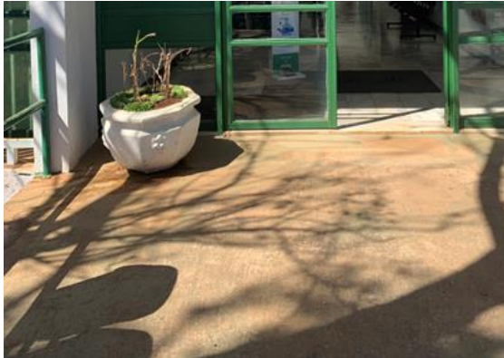
Fig. 2 – Entrada principal norte da FE-3.
