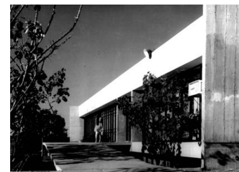
Figura 36 – Rampa de acesso à FE3 pela fachada Norte. Fonte: Arquivo Central UnB.
