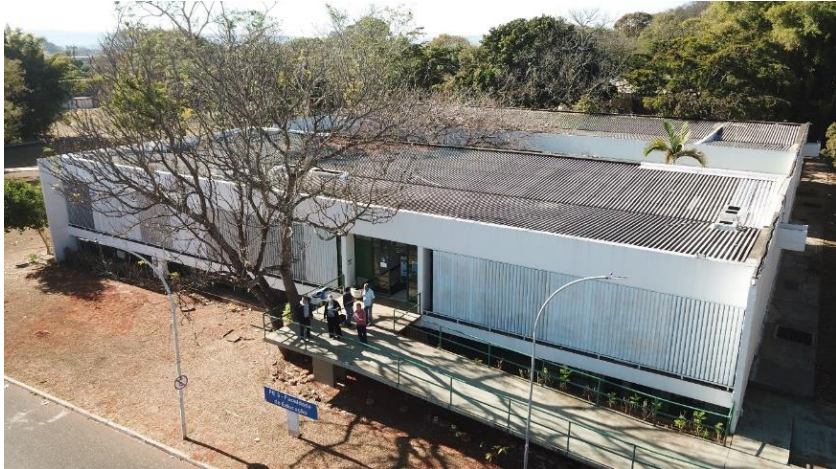
Fig. 2 - Vista da FE-3: arborização intensa ao redor da edificação.
