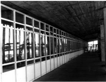
Figura 20 – Esquadria que permite a integração interior/exterior na FE1. Fonte: Arquivo Central da UnB.
