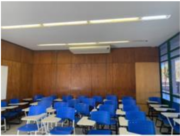
Figura 31 – Divisórias de Madeira na FE1. Fonte: Grupo de Pesquisa Conservação Manutenção, 2022
