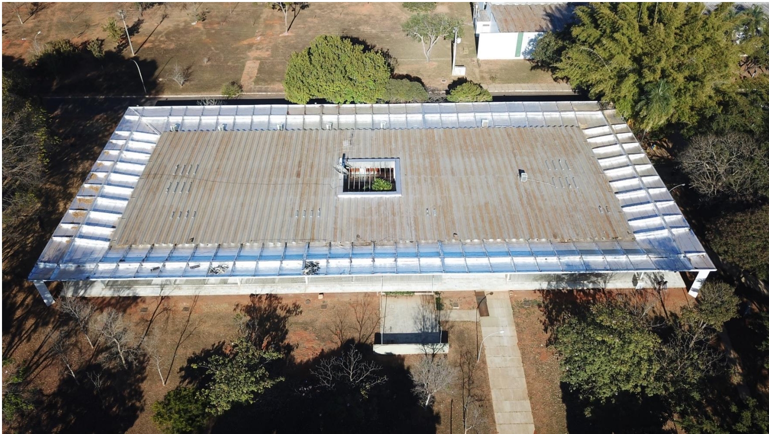
Fig. 1 – Cobertura da FE-1: telhado e laje impermeabilizada.
