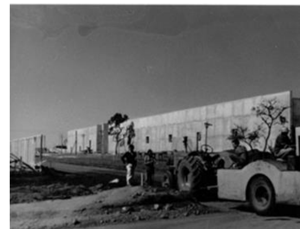
Figura 50 – FE5 em construção onde se vê a fachada Leste com as aberturas quadradas e, ao fundo, os rasgos verticais. Fonte: Arquivo Central da UnB.
