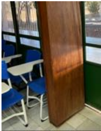
Figura 30– Pilar de concreto revestido. Fonte: Grupo de Pesquisa Conservação Manutenção, 2022.
