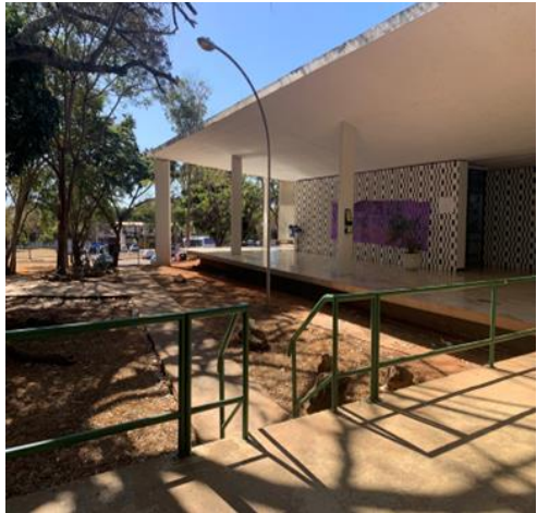
Fig.1 – Guarda-corpo na passarela de ligação entre a FE-1 e FE-3.
