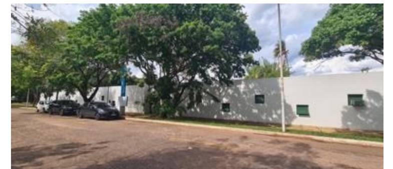
Figura 49 – Fachada Oeste FE5. Fonte: Flaviana Barreto Lira, 2022.
