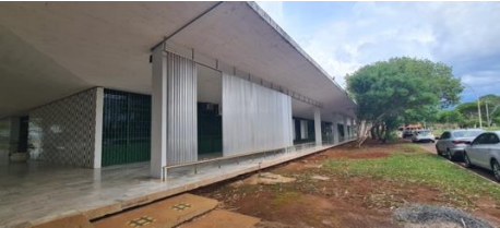
Figura 21 – Brise-soleils na fachada oeste da FE1. Fonte: Flaviana Barreto Lira, 2022.
