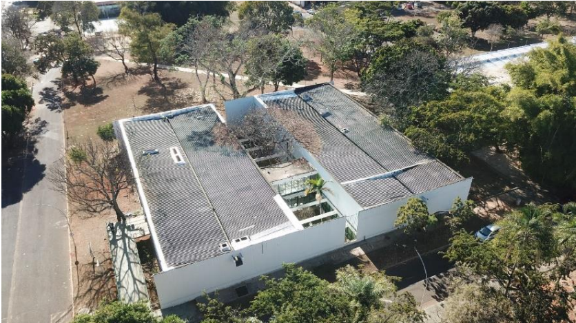
Fig. 1 - Vista aérea da cobertura da FE-3.
