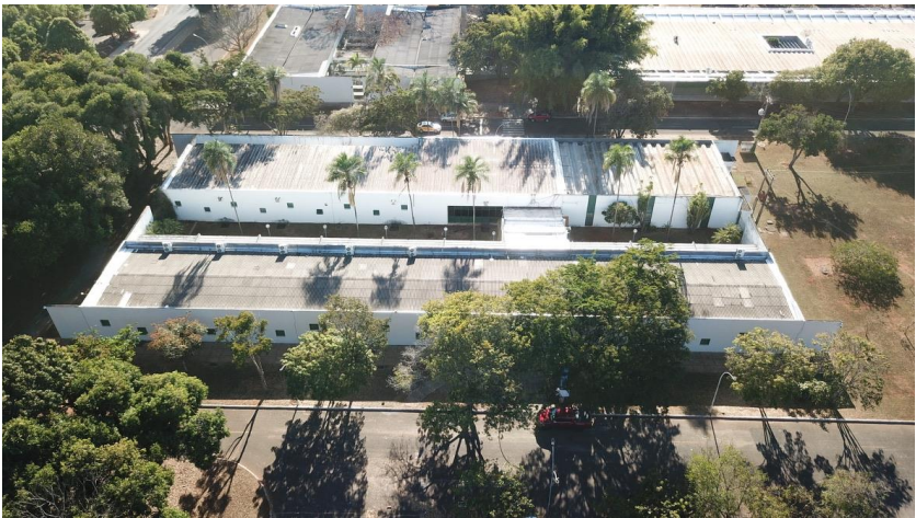
Fig.3 – Vista panoramica da FE-5 e sua cobertura.
