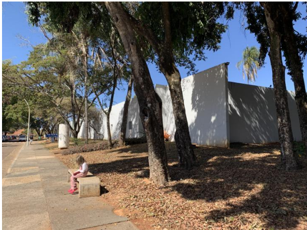
Fig 1 – Elementos externos na fachada leste em bom estado de conservação.
