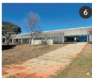
Rampa de acesso
