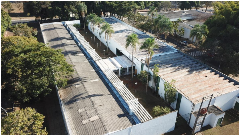
Fig.1 – Vista da fachada Sul, onde se localizada as entradas de energia da edificação.
