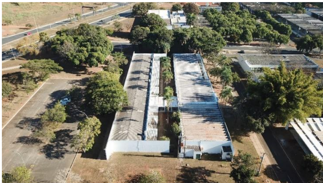
Fig. 1 - Vista aérea da cobertura da FE-5.
