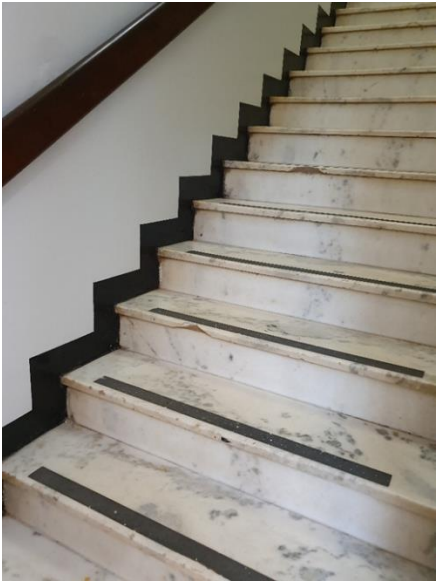
Fig. 4 – Escada revestida com placas de mármore.
