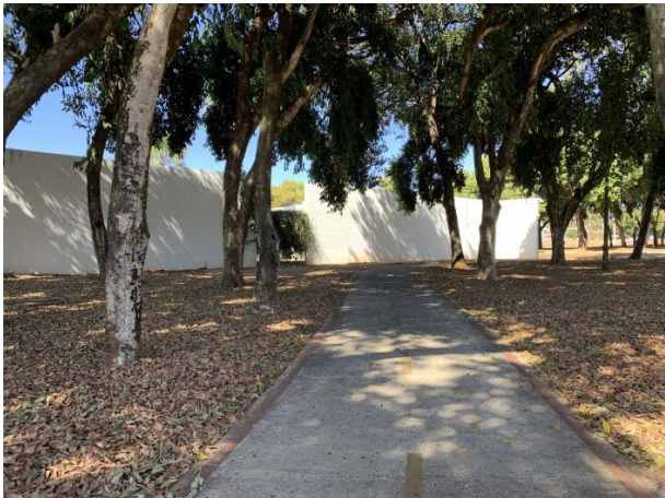
Fig 2 – Ciclovia na fachada norte e elementos externos em bom estado de conservação.
