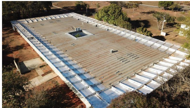
Fig.3 – Telhamento metálico original da cobertura FE-1.
