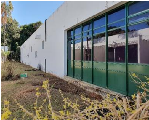
Fig. 1 – Os vidros dos painéis são do tipo comum, e são pintados para diminuir o ofuscamento e visibilidade do interior.
