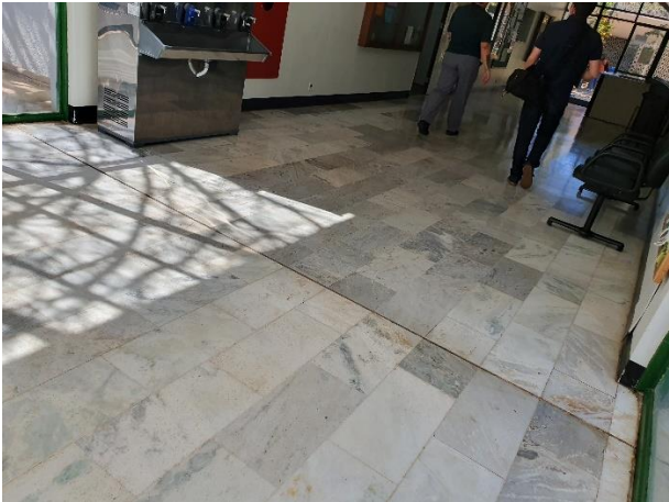
Fig.1 – Circulação interna mostrando a existência da junta de movimento do piso revestido em mármore branco.
