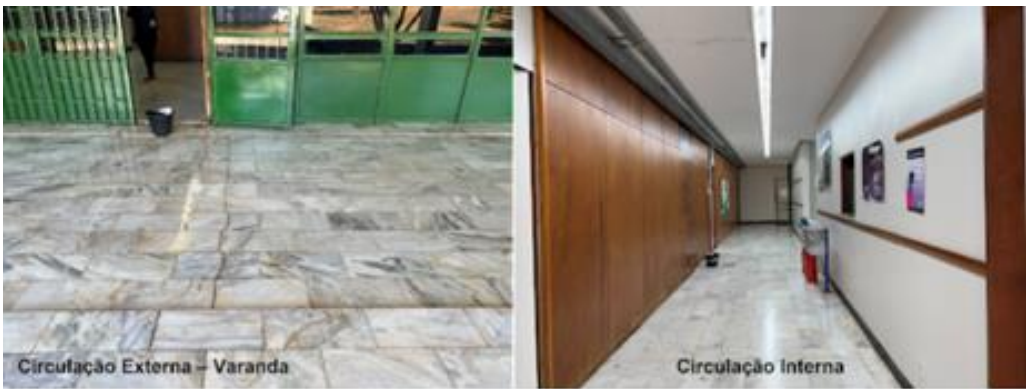
Figura 29 – Piso em mármore branco na varanda e nas circulações da FE1. Fonte: Grupo de Pesquisa Conservação Manutenção, 2022.
