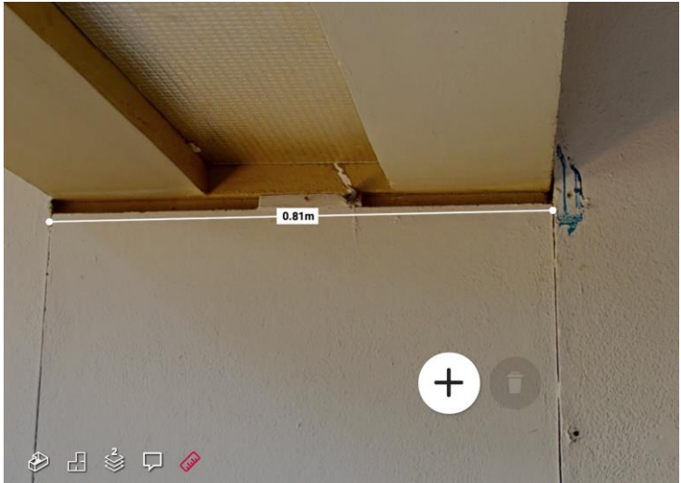
Figura 94 - Exemplo de detalhe e medição de elemento pela plataforma Matterport. Fonte: Autor.
