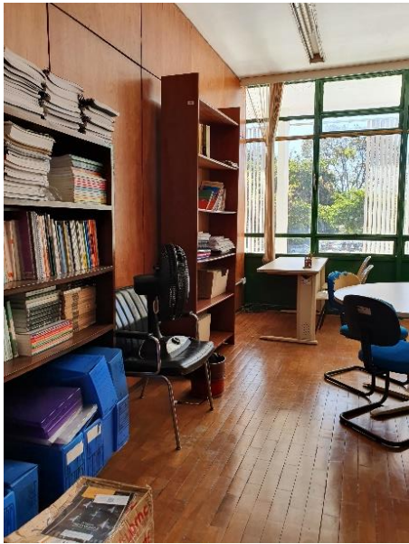
Fig.1 – Pisos de madeira nos ambientes de trabalho.
