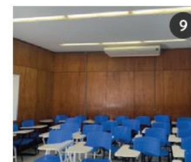
Divisórias de madeira
