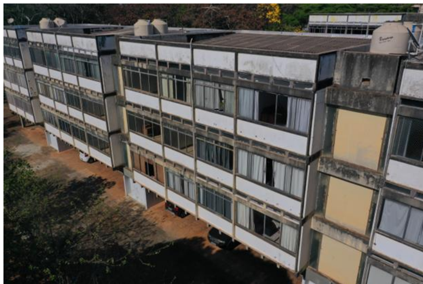
Figura 91 - Fachada do Bloco A – Colina: imagem capturada por drone. Fonte: LaSUS, 2022.
