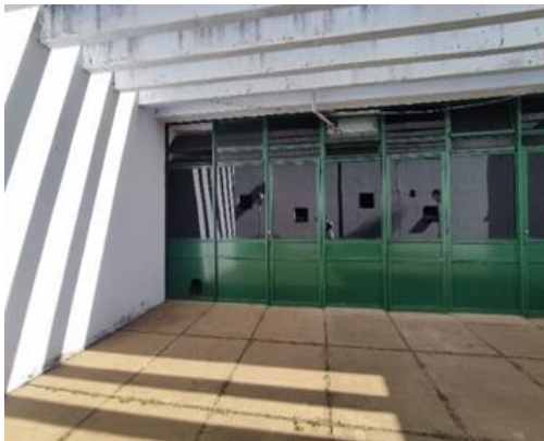
Fig. 2 – Os vidros comuns dos painéis possuem películas para diminuir o ofuscamento e visibilidade do ambiente interior.
