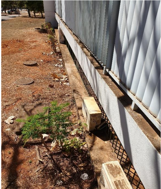
Fig. 4 – Fachada norte com brises e aberturas para a iluminação das salas do subsolo.
