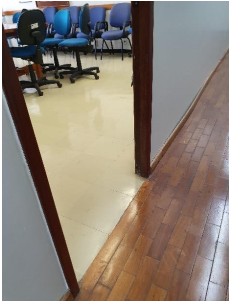
Fig. 2 – Substituição dos pisos originais de madeira por placas vinílicas do tipo Paviflex.
