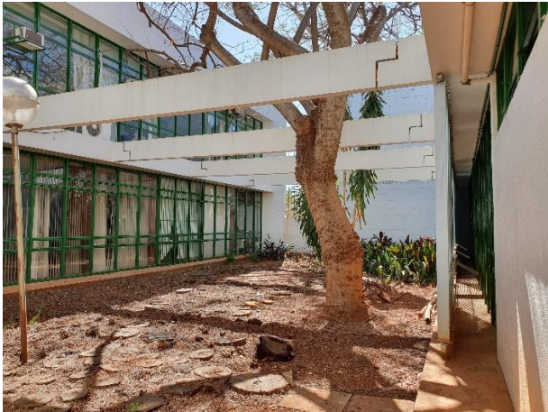
Fig.2 – Jardim interno da FE-3: calçada de contorno que protege as paredes e painéis envidraçados do subsolo.
