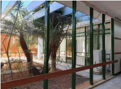
Fig. 5 - Vista do jardim do pátio central da FE – 1.
