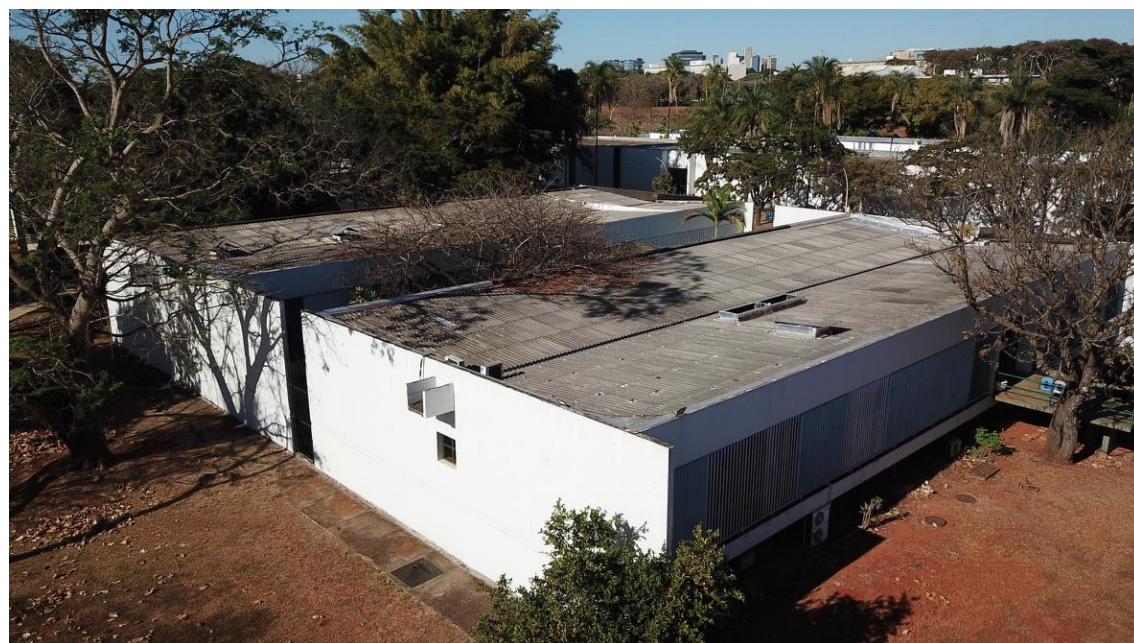
Fig. 1 - Vista da FE-3: fachada leste e fachada norte
