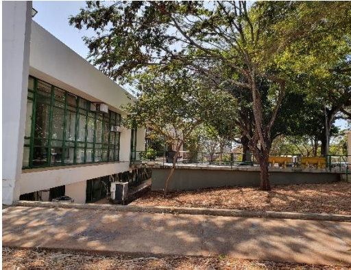
Fig. 1 – Vista da área externa – lateral sul.
