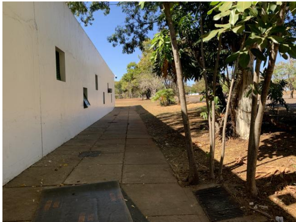
Fig 3 – Calçamento da fachada oeste com juntas e placas em bom estado de conservação.
