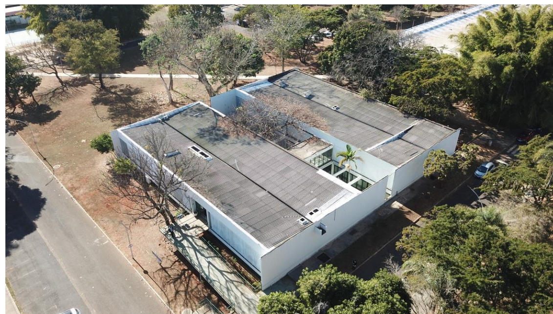
Fig. 2- Vista da FE-3: fachada norte e fachada oeste
