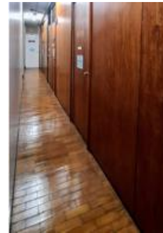
Figura 33 – Divisória de madeira como parte do sistema de vedação vertical interno. Fonte: Flaviana Barreto Lira, 2022.
