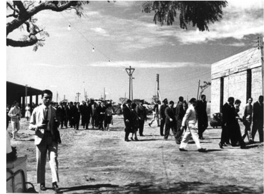
Figura 58 – Fachada Leste da FE 5 durante construção (à direita), mostrando a vedação vertical em alvenaria.
