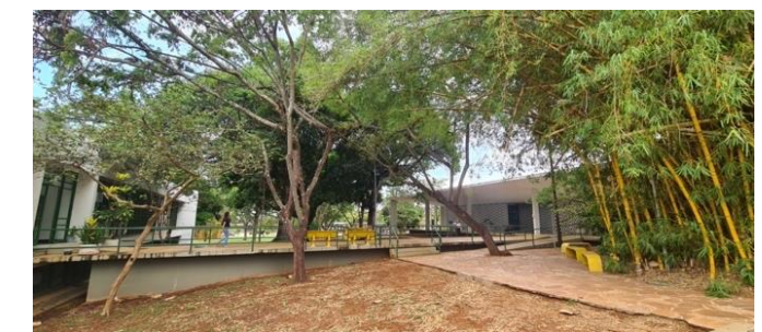
Figura 37 – Passarela/ponte de ligação cruzando jardim público e interligando os edifícios da FE1 (à direita) com o da FE3 (à esquerda). Fonte: Flaviana Barreto Lira, 2022.
