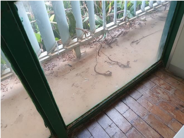
Fig.3 – Calçada de contorno no jardim interno para proteção da base dos painéis metálicos envidraçados.
